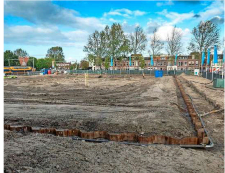
Bouwwerkzaamheden bij Plaza West. In dit gedeelte van de spoorzone komen zeshonderd van de tweeduizend woningen. ARCHIEFFOTO
